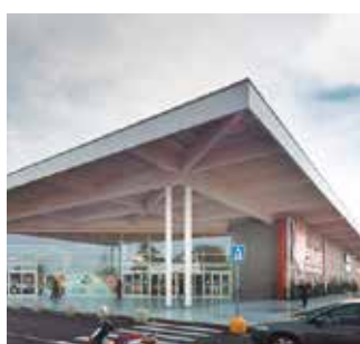
Centre Commercial 40 000 m 2 avec 40 espaces commerciaux. ECOi
