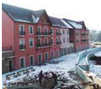
Maison de retraite de Montcenis. Plus de 6100 m 2 et 85 chambres. ECO-G
