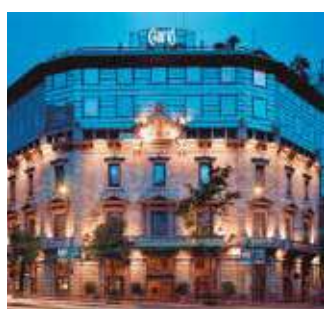
Rénovation d'un hôtel. Hôtel Claris 5*. ECOi
